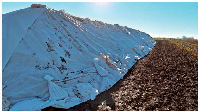
Pryzma zabezpieczona workami z ziemią i przywiązanymi do nich sznurkami
