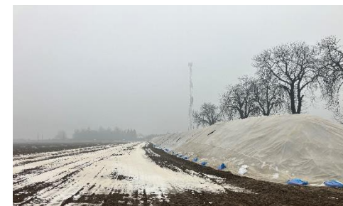
prawidłowo zabezpieczona workami z piaskiem podstawa pryzmy
